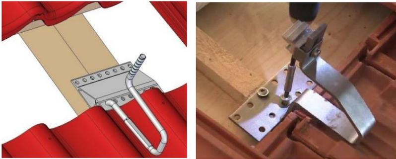
**Alternative :** remplacer ponctuellement les tuiles au niveau des fixations par des éléments conçus à cet effet
