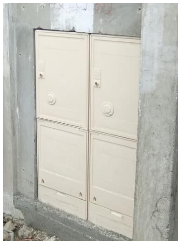
Exemples de mise en oeuvre de CCPC
